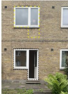
Overskydende mursten fra vindueren- overing anvendes til base
