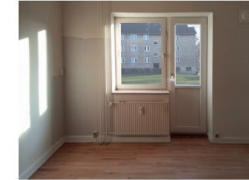
Renoverings forstel til byggeriet
